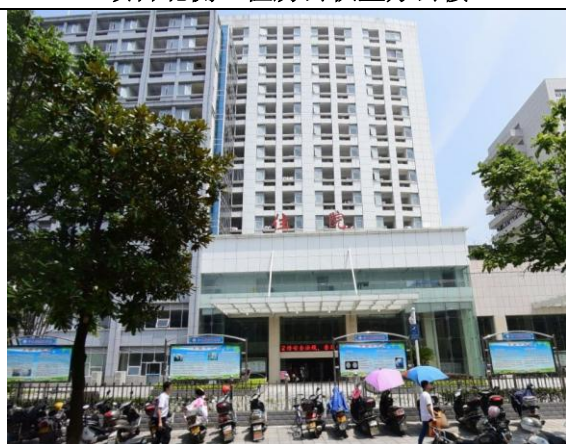
项目南侧 沙县总医院现状住院大楼
