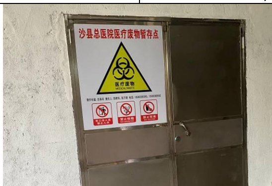
沙县总医院现有医疗废物暂存间
