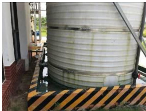
综合处理车间乙酸钠储罐围堰
