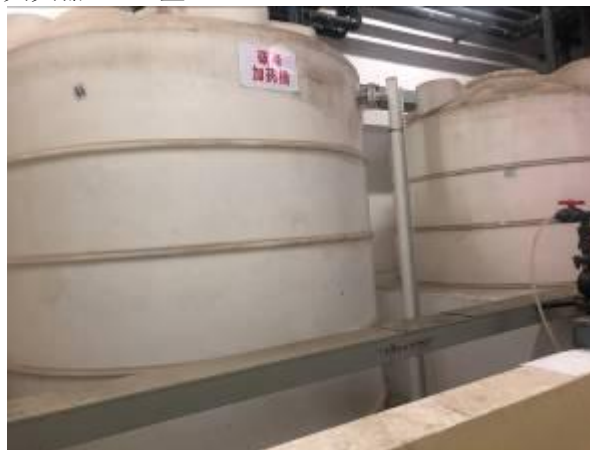
乙酸钠溶液储罐围堰
