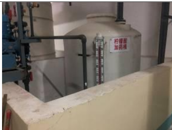
柠檬酸钠溶液储罐围堰
