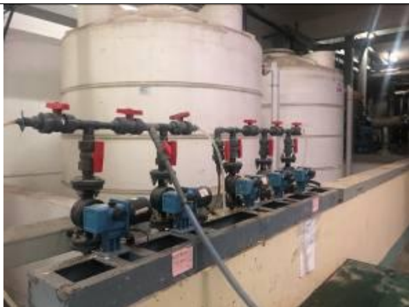
PAC 溶液储罐围堰
