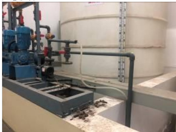
次氯酸钠溶液储罐围堰
